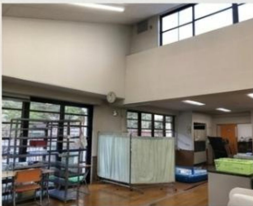
改修前の作業室
